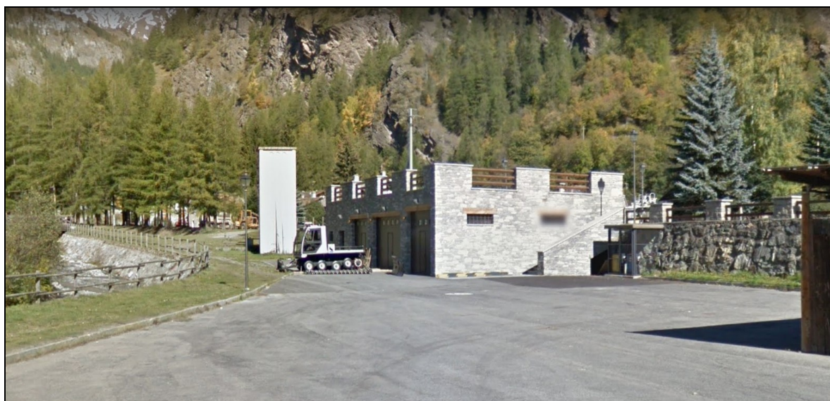
Foto 10: CABINA-TORRE ESISTENTE CHE VERRÀ SMANTELLATA (FONTE GOOGLE MAPS)
