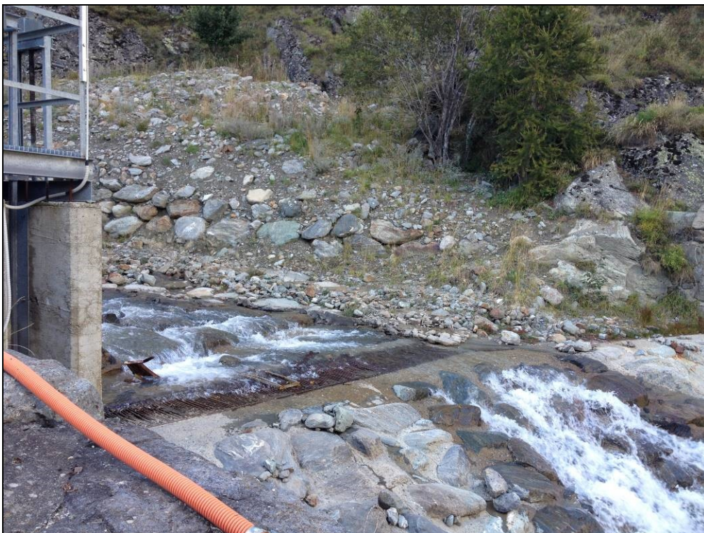
Foto 4: PRESA SUL T. BERROVARD CHE VERRÀ DISMESSA
