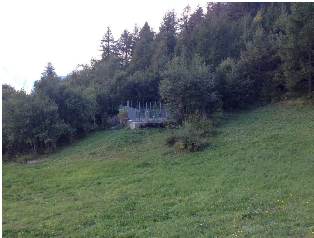
Foto 5: VASCA ESISTENTE DEL CMF AL T. BERROVARD E VASCA DI CARICO DELLA CENTRALE, BACINO RICETTORE DELLE ACQUE DEL T. EAUX BLANCHES
