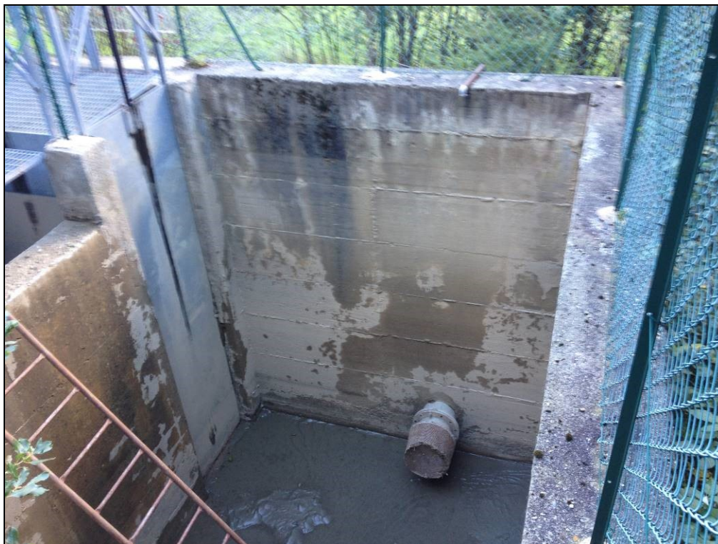
Foto 7: VASCA ESISTENTE DEL CMF AL T.BERROVARD E VASCA DI CARICO DELLA CENTRALE, TUBAZIONE IRRIGUA, FUTURA CONDOTTA FORZATA DELL'IMPIANTO
